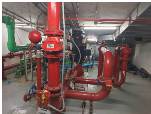
รูปที่ 26 Mian Fire Pump และ Jacky
