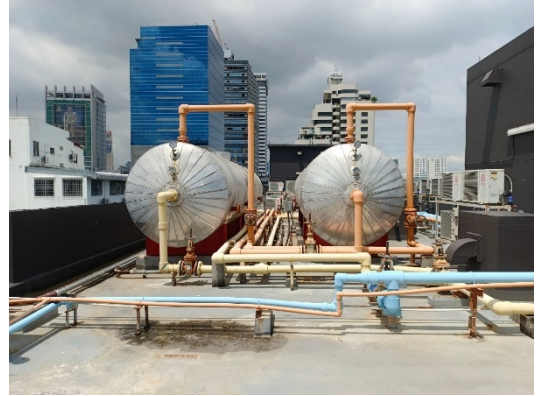
รูปที่ 8 ถังเก็บน้ำสำรองของโครงการ
